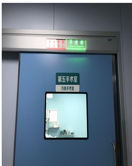
手术室人员进出防护门
